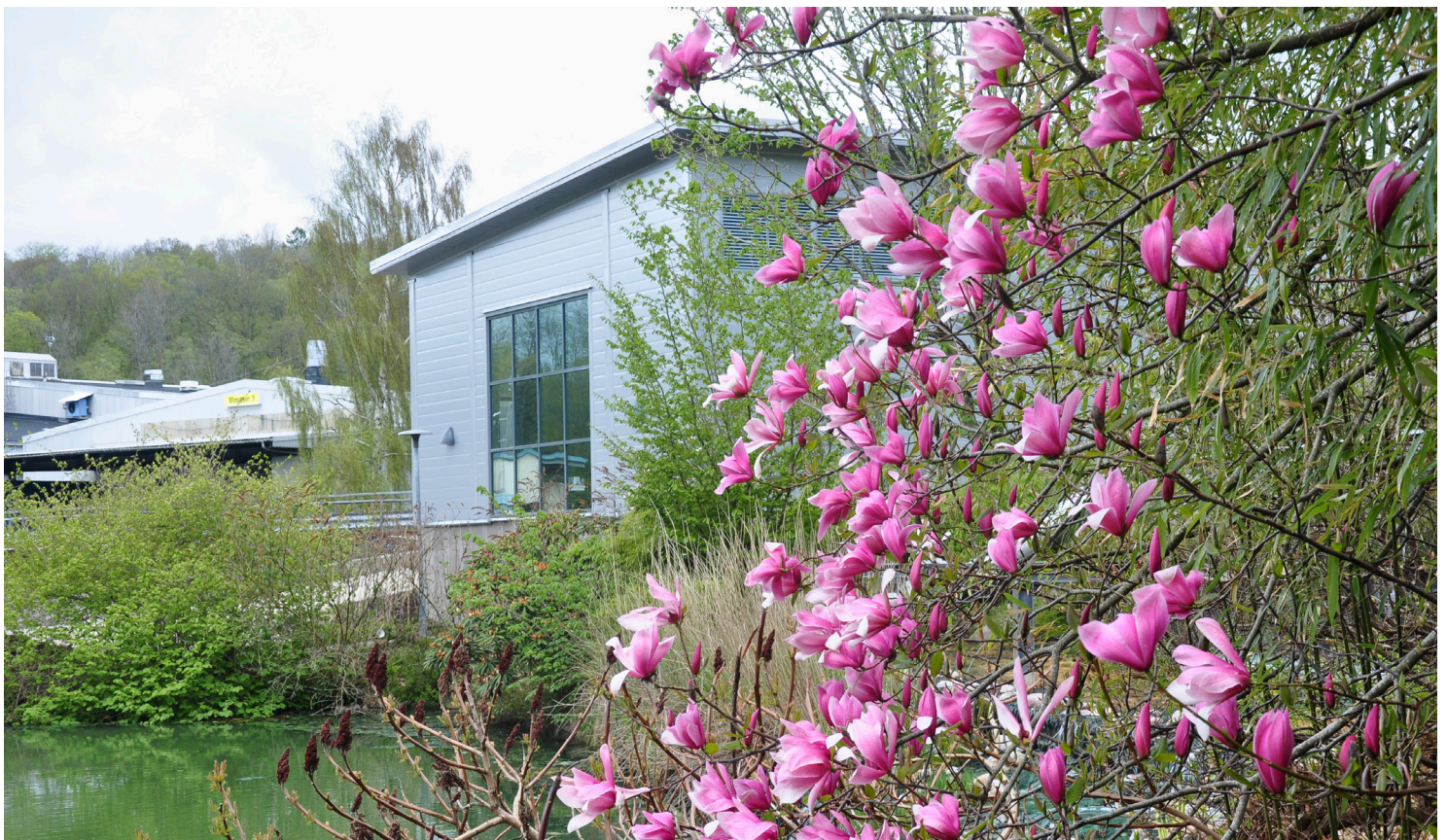
Magnolia Spectrum framför Munkedals nya vattenkraftsbyggnad
